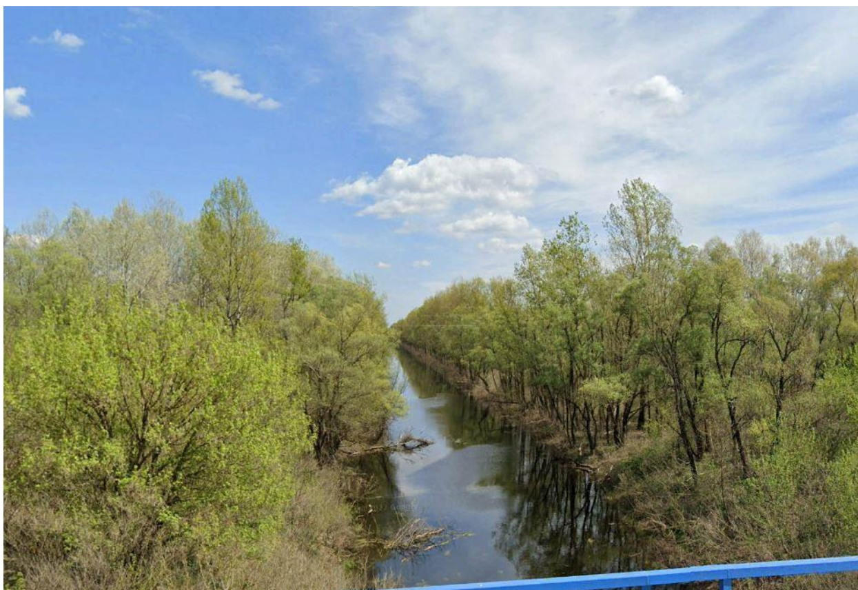
Slika 2. Pogled na kanal
